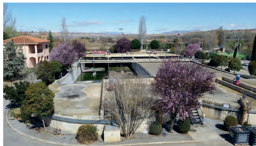
Imagen 7: EDAR de Guadix. Fuente: Aguas de Guadix.
