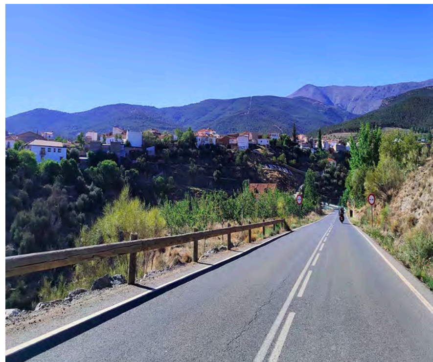
Fig. 20. Carretera de acceso a Albuñán.
