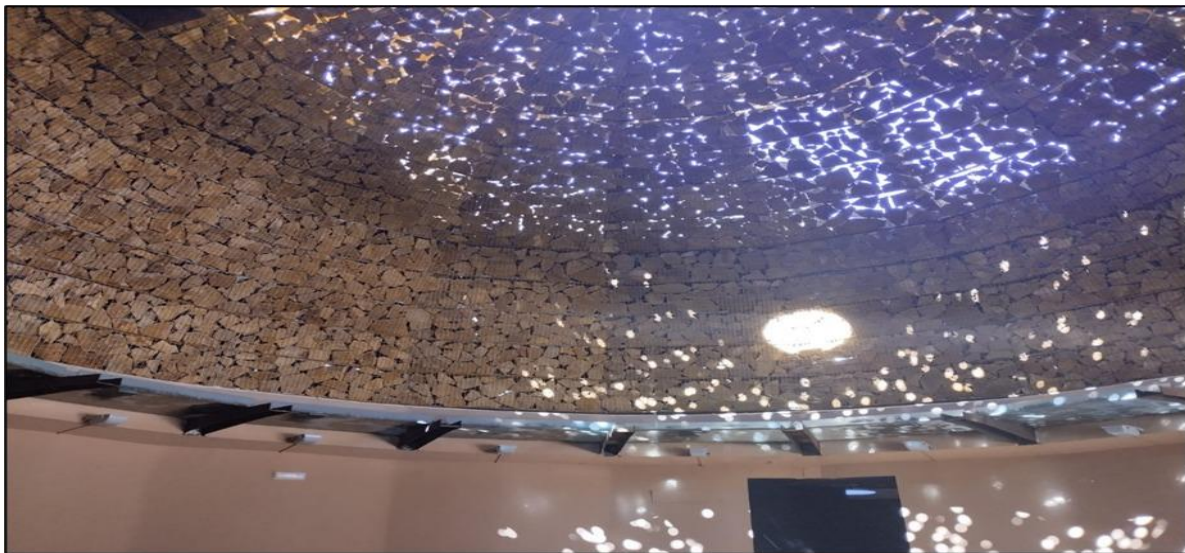
Fotografía 3: Fotografía de la bóveda de la zona central del Centro de Interpretación.
