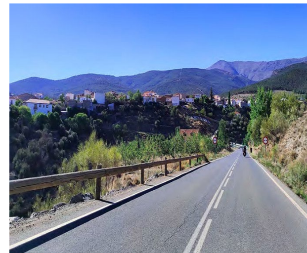
Carretera de acceso a Albuñán
