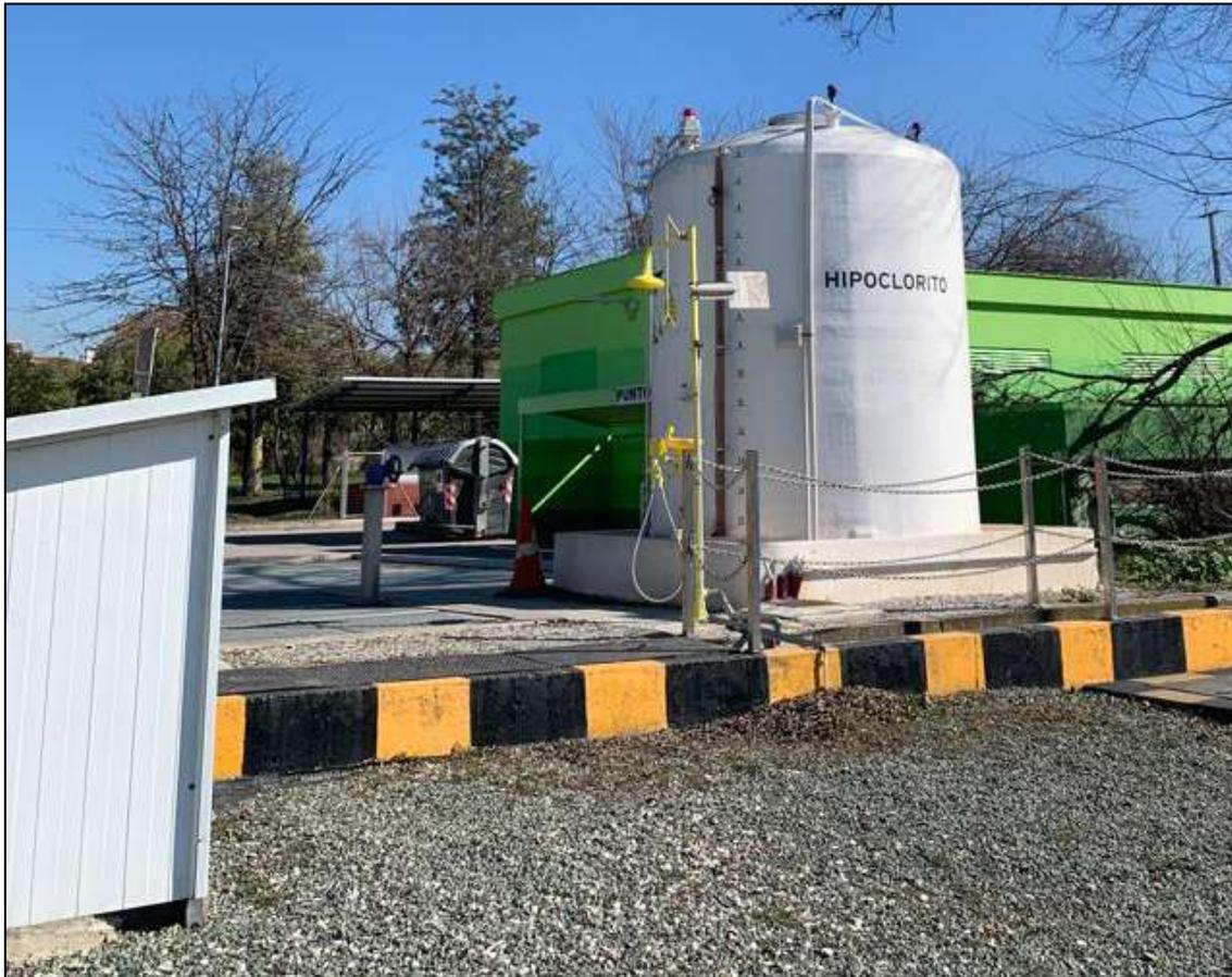
Image 18: Tanque de hipoclorito de sodio de la EDAR Sur de Emasagra. Realizada por Almudena Sanchez.
