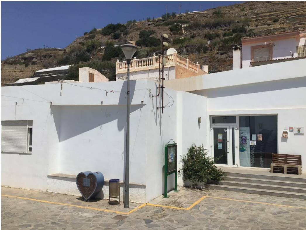
Figura 19. Edificio CIE de usos múltiples en Los Yesos, Sorvilán.
