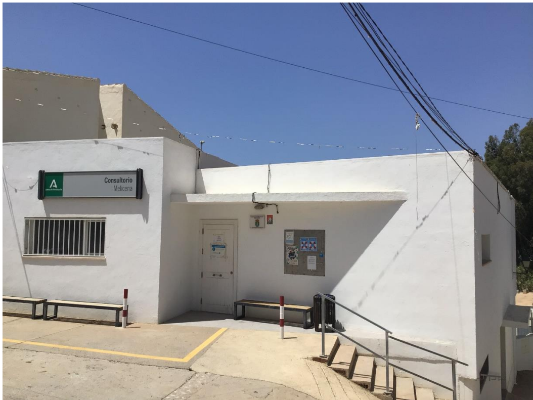
Figura 20. Edificio CIE de usos múltiples en Melicena, Sorvilán.
