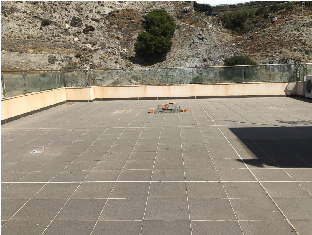
Figura 14. Cubierta donde se colocarían las placas del ayuntamiento de Polopos-La Mamola.
