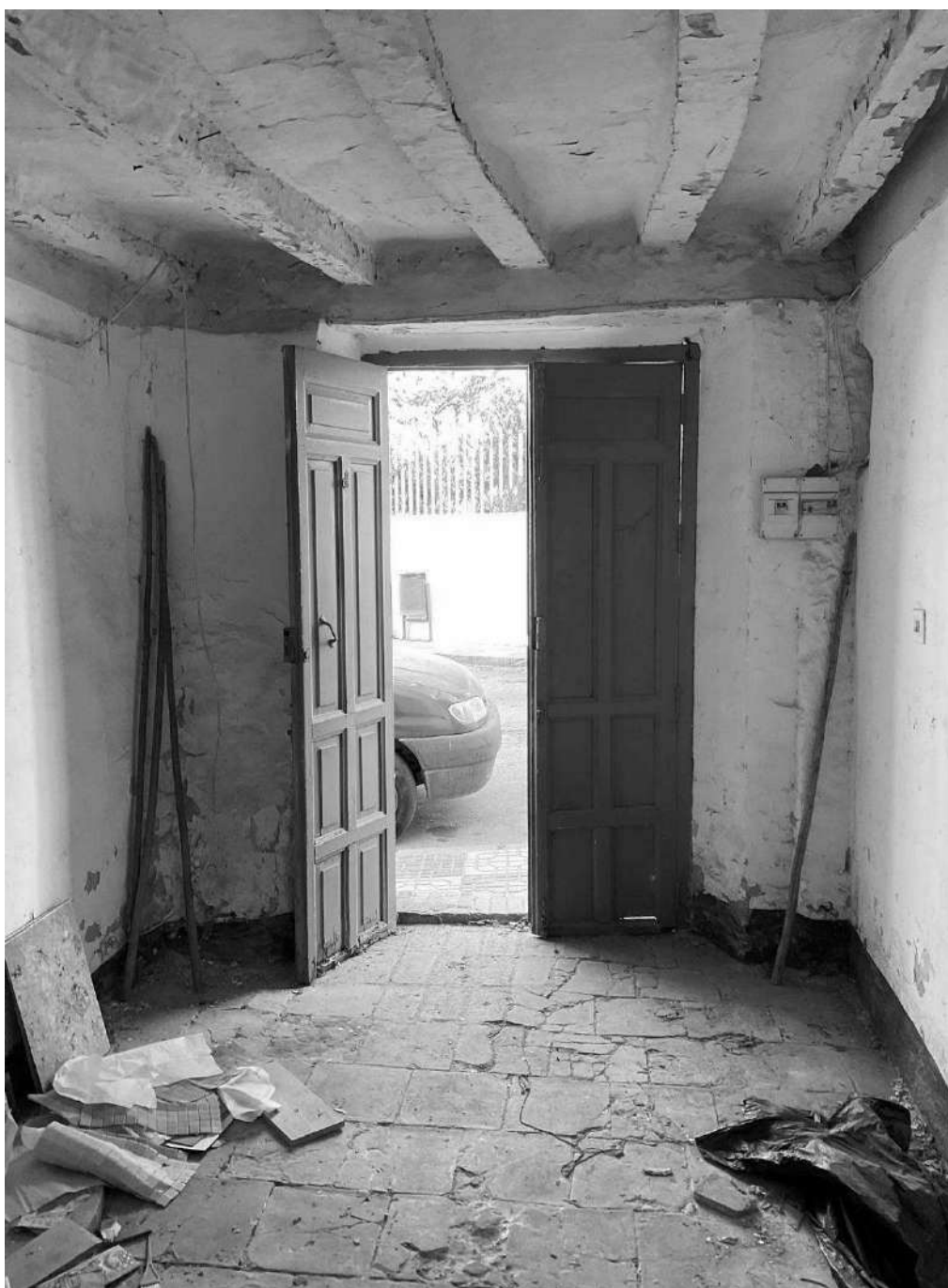
Zagúan. Estado original. Octubre 2022 1
