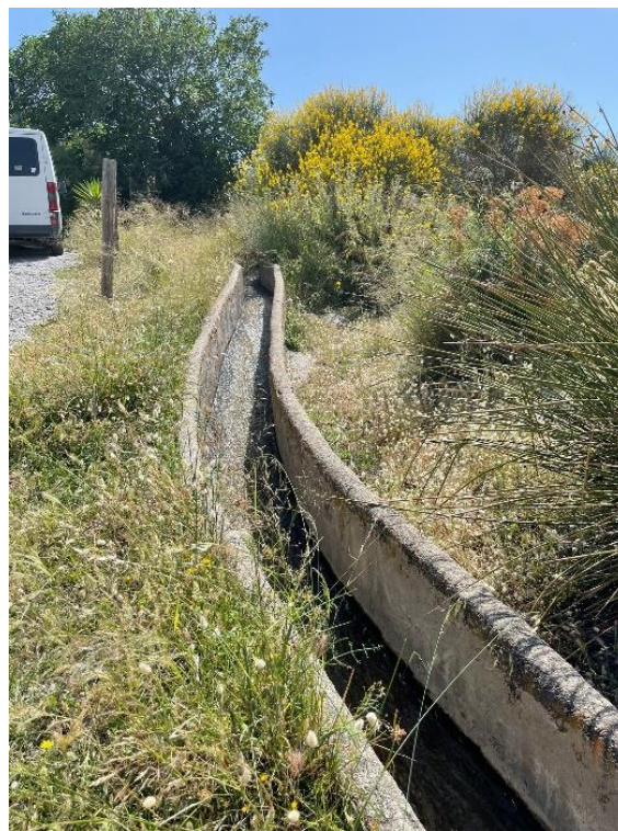
Ilustración 8 Rehabilitación de acequia de regadío
