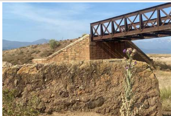
Figura 57. Estado actual del puente ferroviario de Fiñana. Fotografía del autor, 2026.
