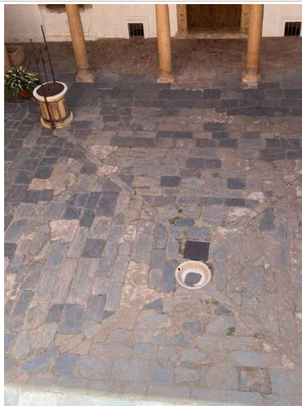
Figura 93. Pavimento del patio y elementos de atrezzo vinculados al rodaje. Fotografía del autor, 2026.
