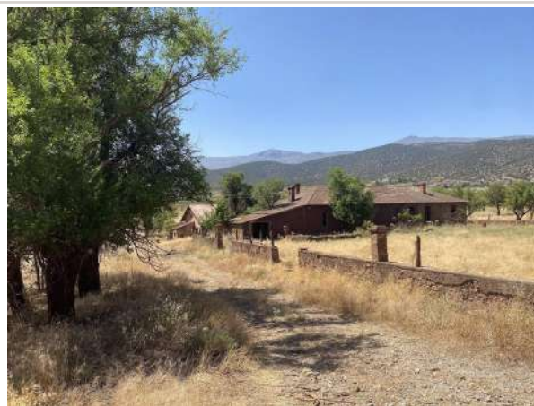
Figura 71. Estado actual de las viviendas situadas junto al parque del poblado minero. Fotografía del autor, 2026.
