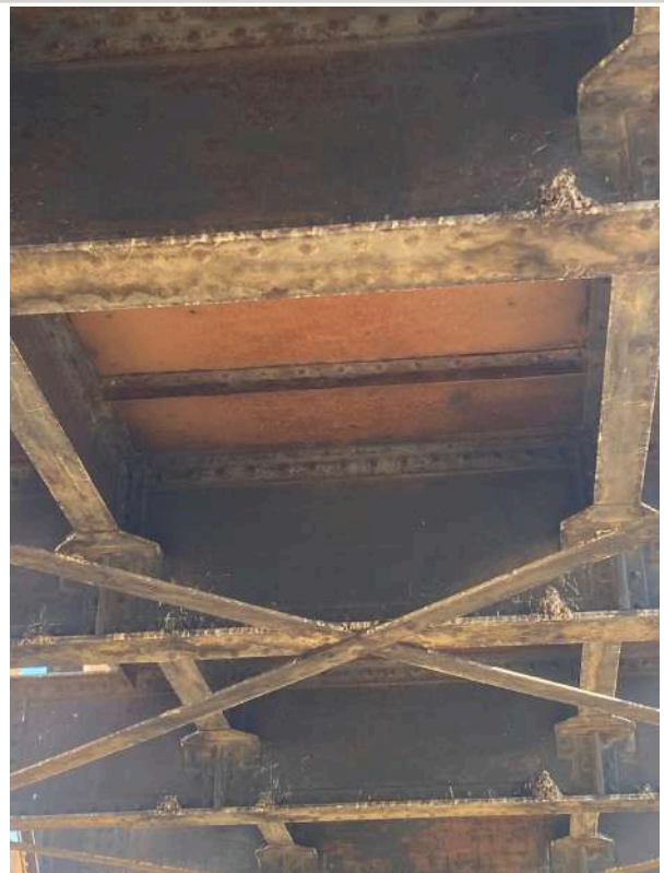
Figura 7. Detalle actual de la estructura metálica inferior del puente. Fotografía del autor, 2026.
