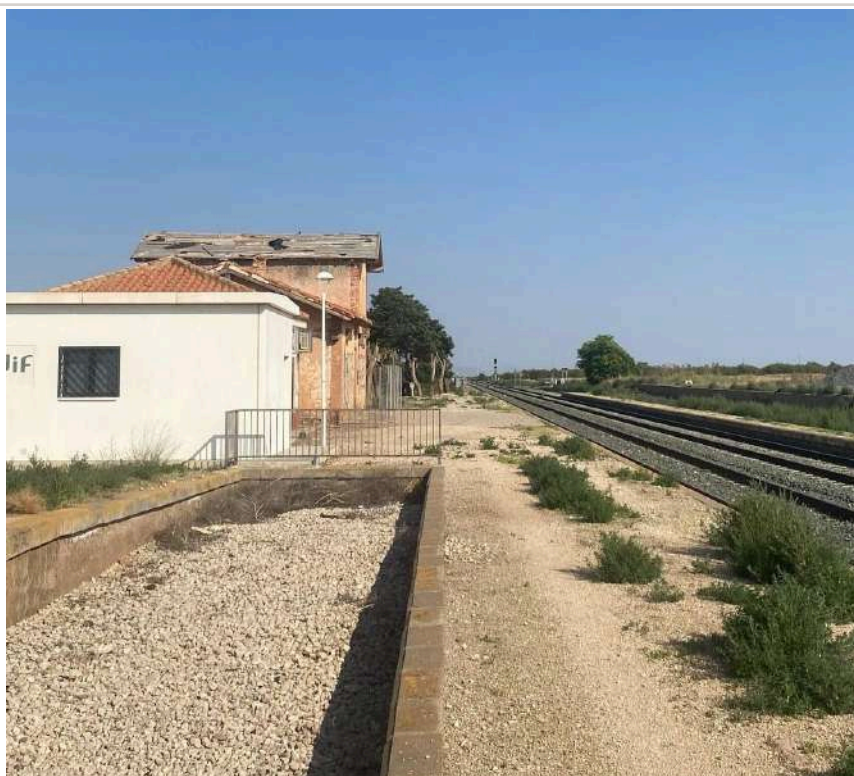
Figura 19. Estado actual de la estación de La Calahorra-Ferreira. Fotografía del autor, 2026.
