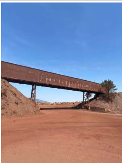
Figura 70. Estado actual del puente industrial del recinto minero. Fotografía del autor, 2026.
