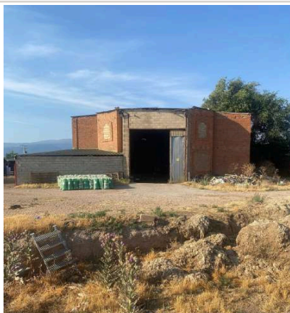
Figura 26. Estado actual del edificio asociado al saloon de Flagstone. Fotografía del autor, 2026.
