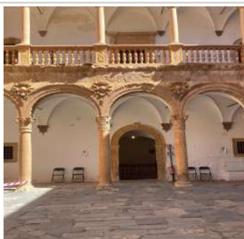
Figura 82. Estado actual del patio renacentista. Fotografía del autor, 2026.
