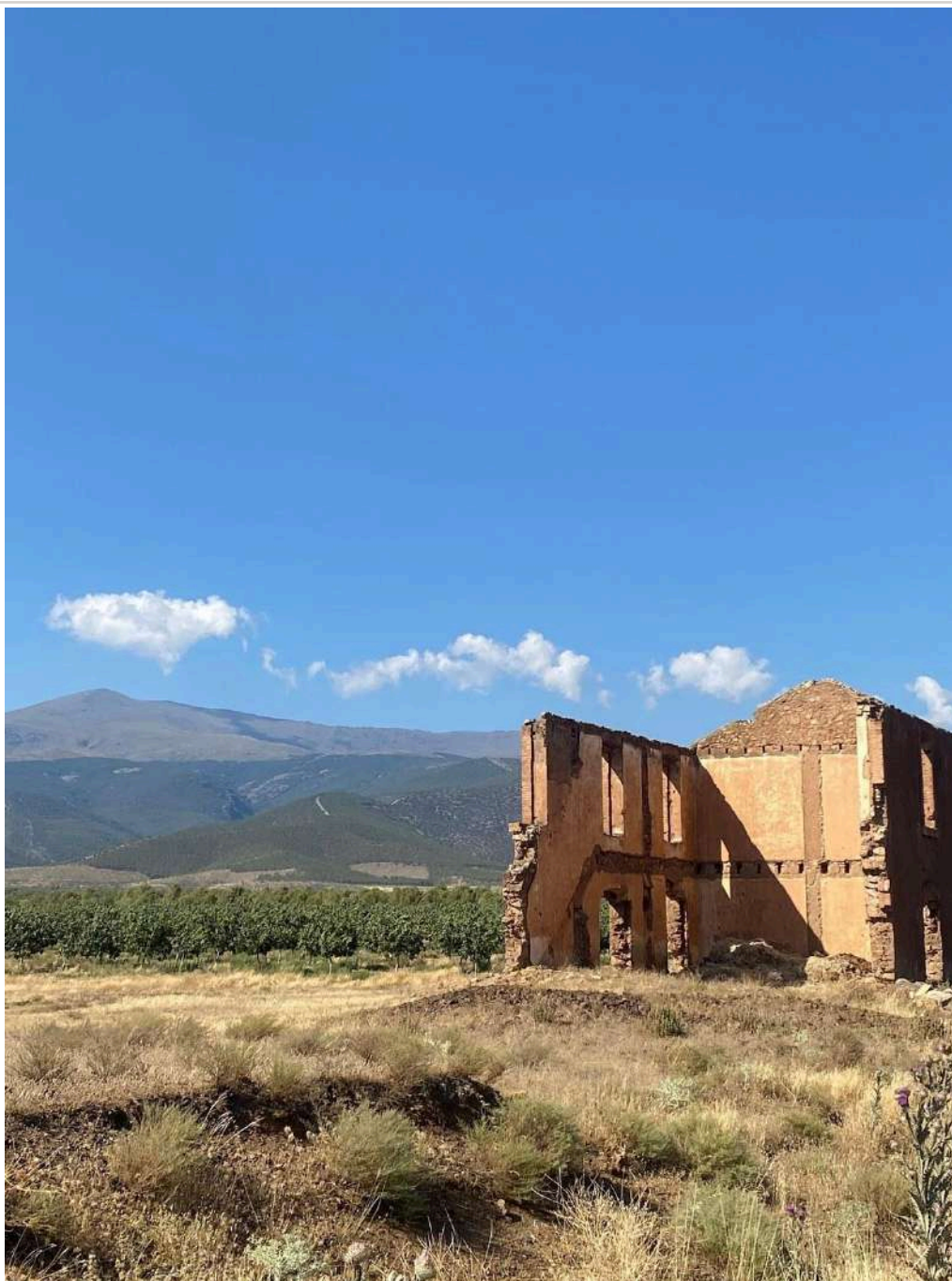
Figura 55. Estado actual de los restos de la cantina destruida. Fotografía del autor, 2026.
