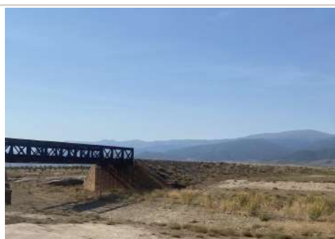
Figura 32. Estado actual del puente ferroviario de la rambla de Fiñana. Fotografía del autor, 2026.
