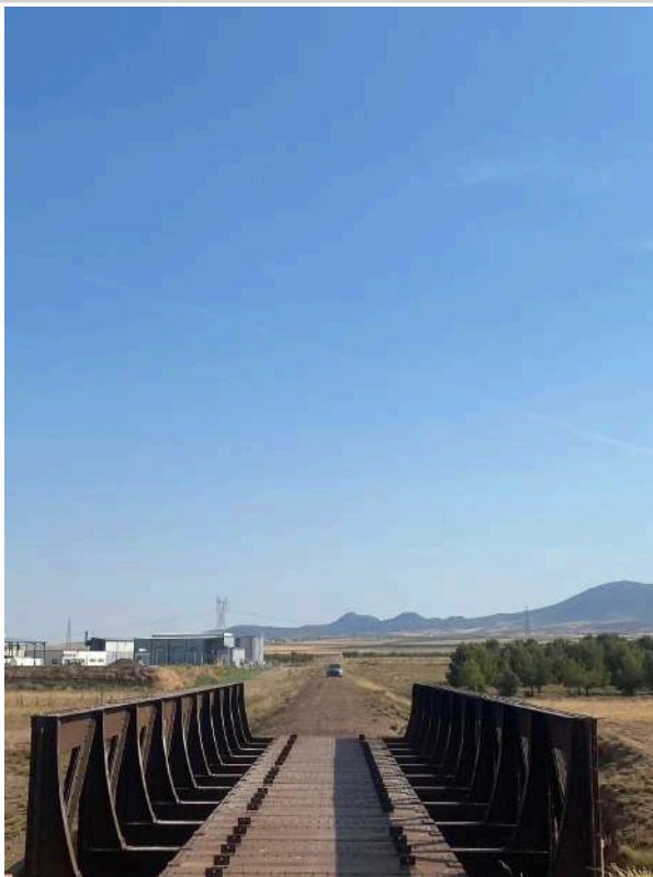
Figura 6. Vista actual del tablero del puente ferroviario. Fotografía del autor, 2026.
