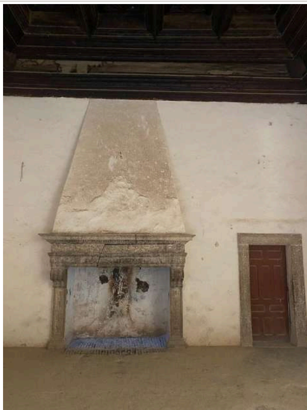
Figura 92. Chimenea monumental utilizada como fondo en la serie. Fotografía del autor, 2026.
