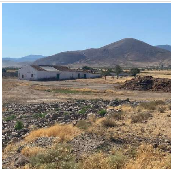
Figura 54. Estado actual del cortijo cercano a Alquife. Fotografía del autor, 2026.
