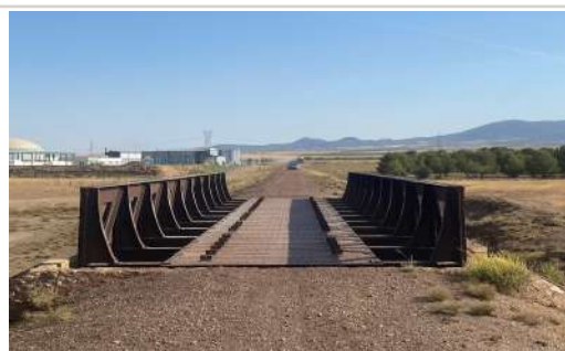
Figura 11. Estado actual del puente ferroviario de la rambla de Fiñana. Fotografía del autor, 2026.
