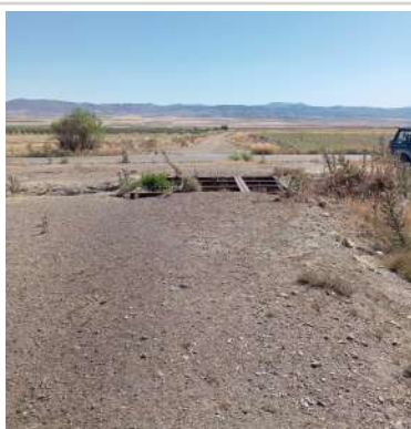
Figura 33. Estado actual del punto situado antes de Cattle Corner. Fotografía del autor, 2026.
