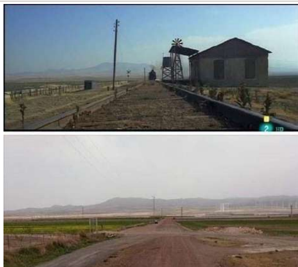
Figura 43. Comparativa de la estación ficticia y del lugar tras la demolición del edificio. Fuente: Francisco Arco, El western en la provincia de Granada (1961-1984), II, Cerebrin, 27 de julio de 2021.
