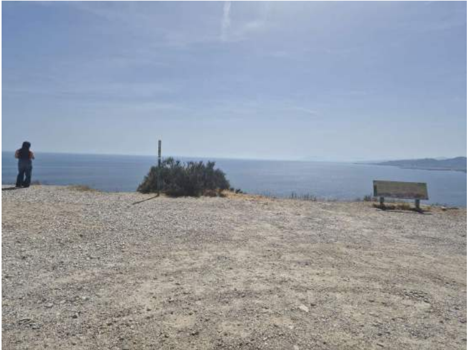
Imagen 1.10. Mirador en construcción en Cerro Gordo.
