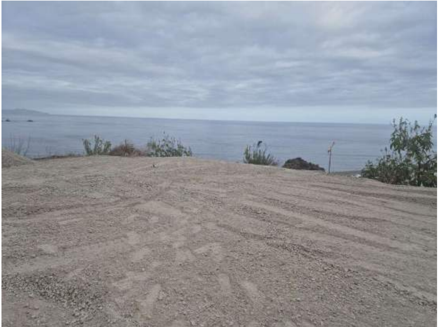
Imagen 3.1.2. Primer mirador en construcción.
