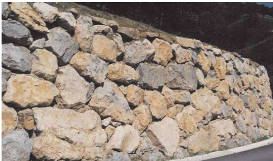
Ilustración 27- Muro de escollera
