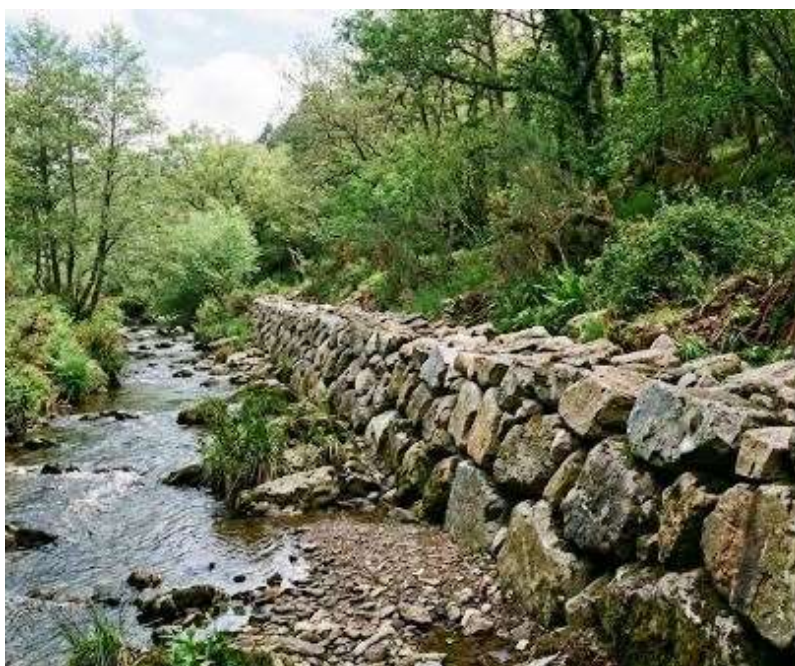
Ilustración 23- Muro de escollera
