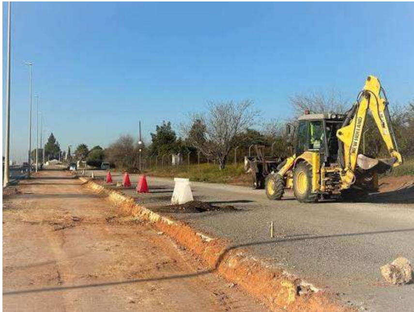
Ilustración 25- Movimiento de tierras
