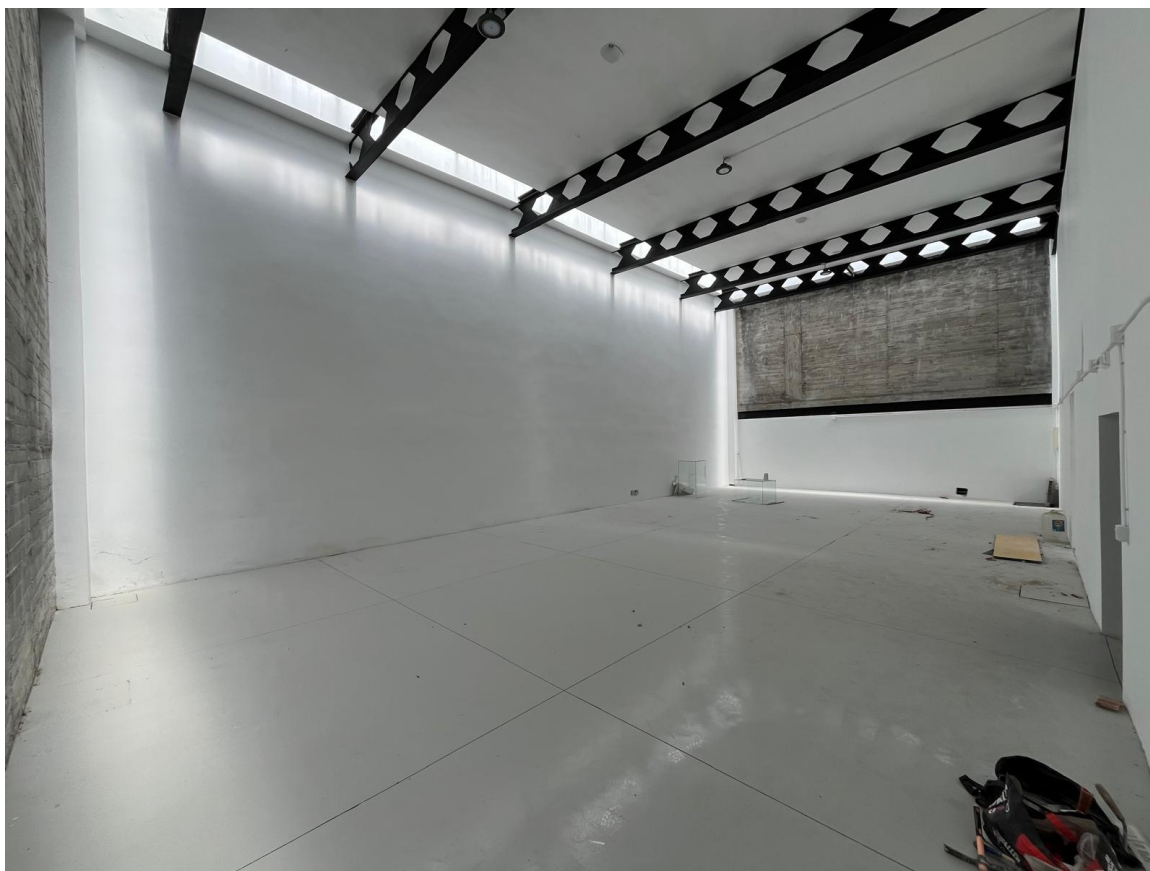
Figura VII. Vista real del estado actual de la Sala de actos auxiliar durante de la reforma.
