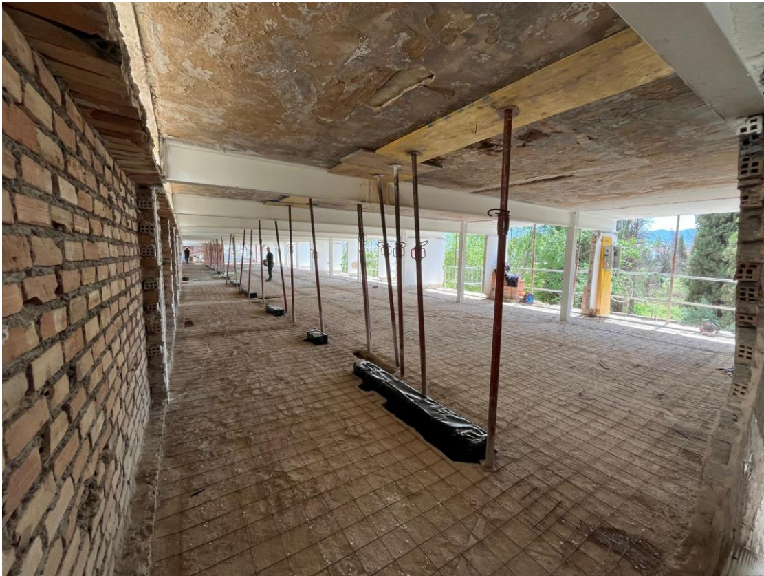
Figura III. Vista real del estado actual de las oficinas durante de la reforma.
