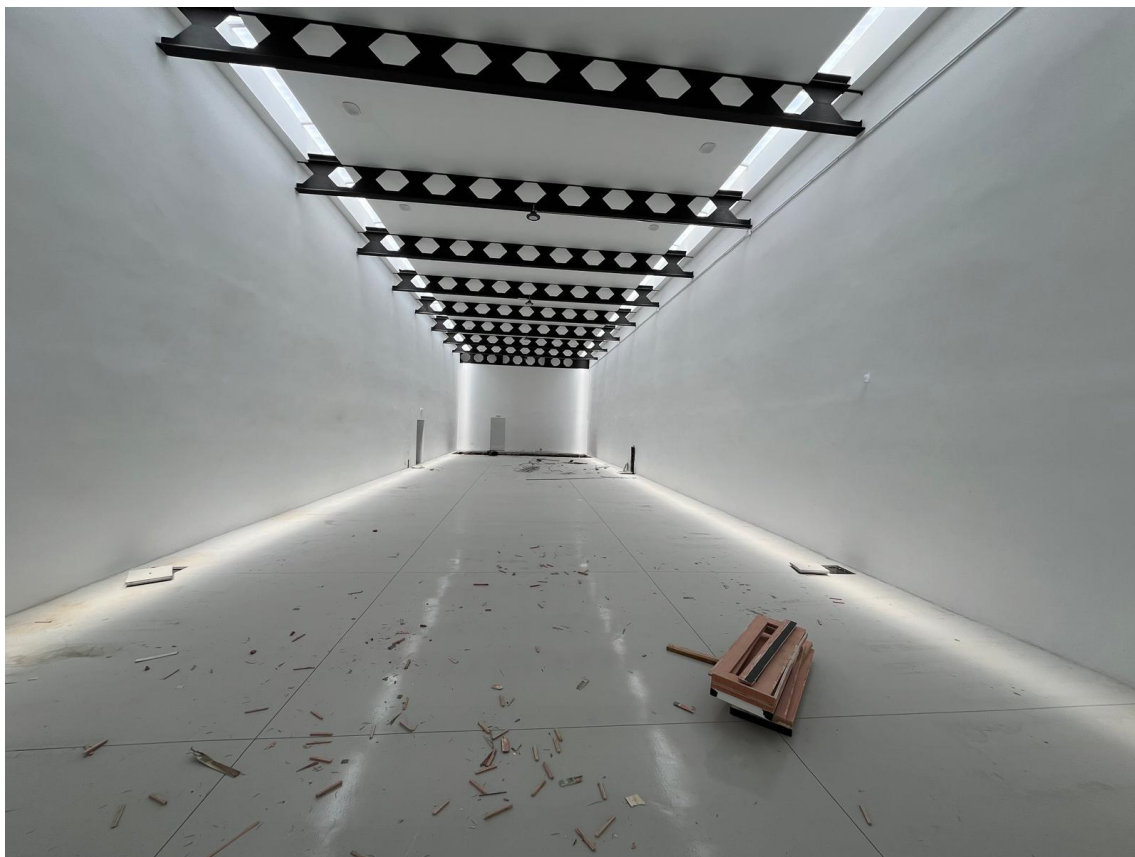
Figura V. Vista real del estado actual del Salón de Actos durante de la reforma.
