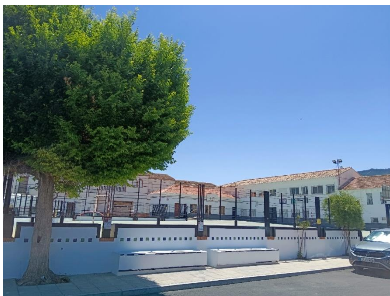
Figura 8. Antiguo colegio de Restábal. La fotografía incluye el patio y el edificio principal, quedando a la espalda la cocina y a la izquierda el edificio complementario. Fuente: Elaboración propia.
