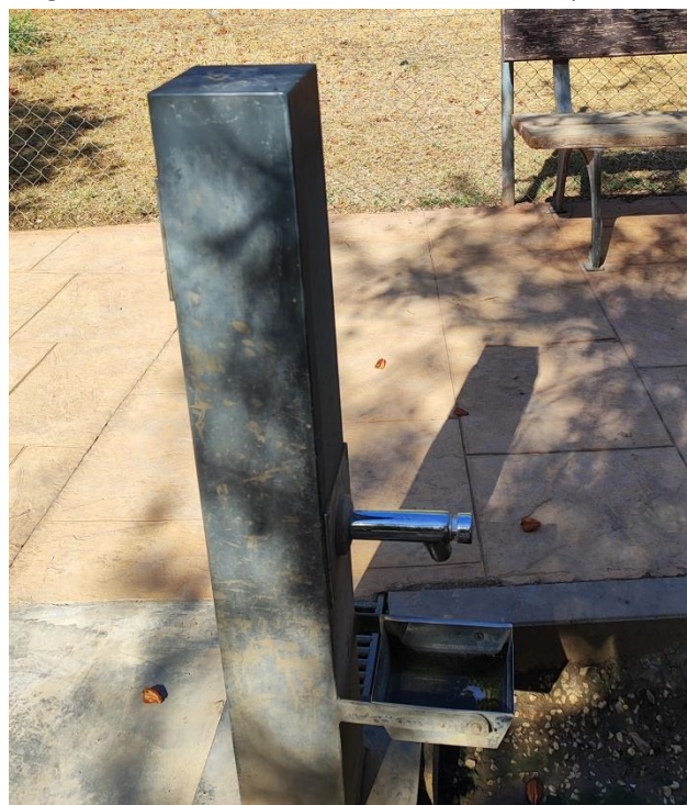
Imagen 39. Fuentes acondicionadas del Parque Canino
