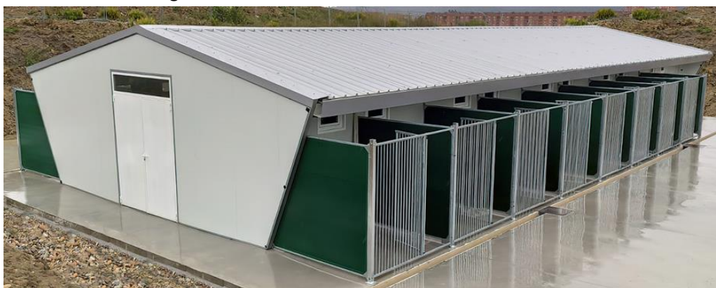
Imagen 41. Nave modular Mekanaves – Centro canino
