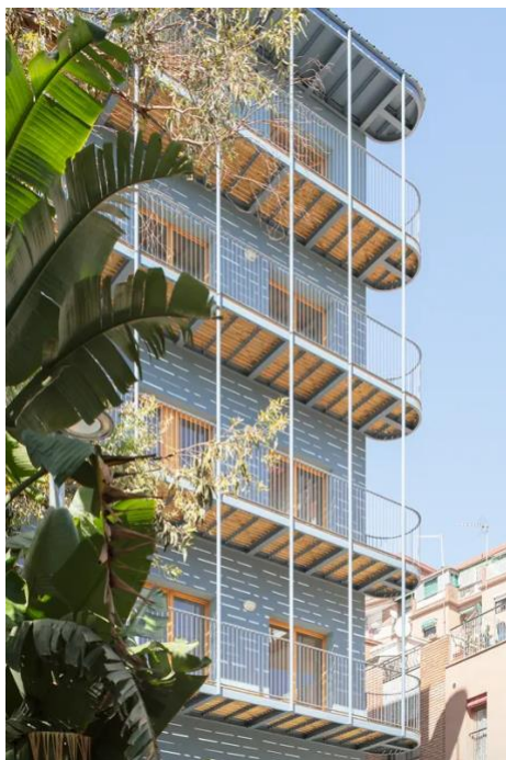
Imagen 17. Edificio de La Morada
