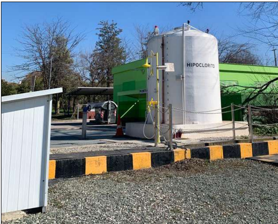
Image 18: Tanque de hipoclorito de sodio de la EDAR Sur de Emasagra. Realizada por Almudena Sanchez.
