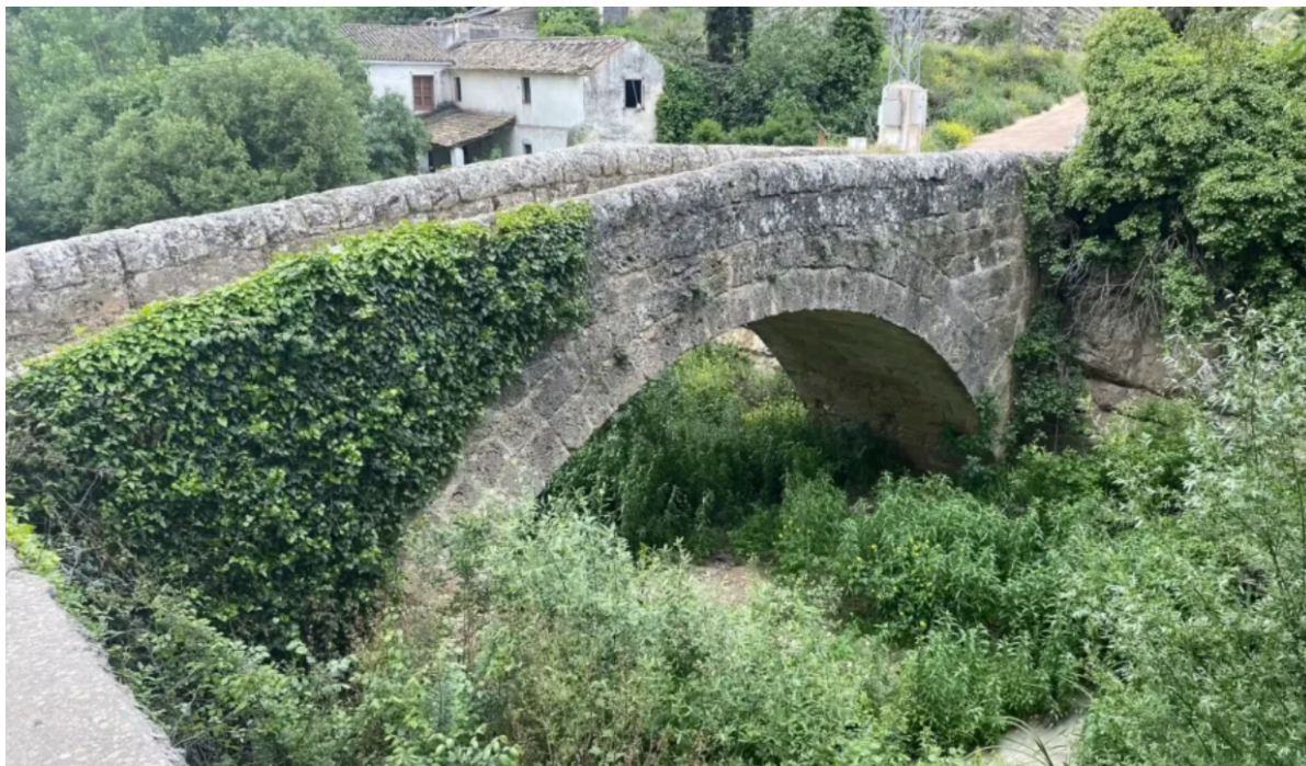
F.4 Puente romano de Colomera
