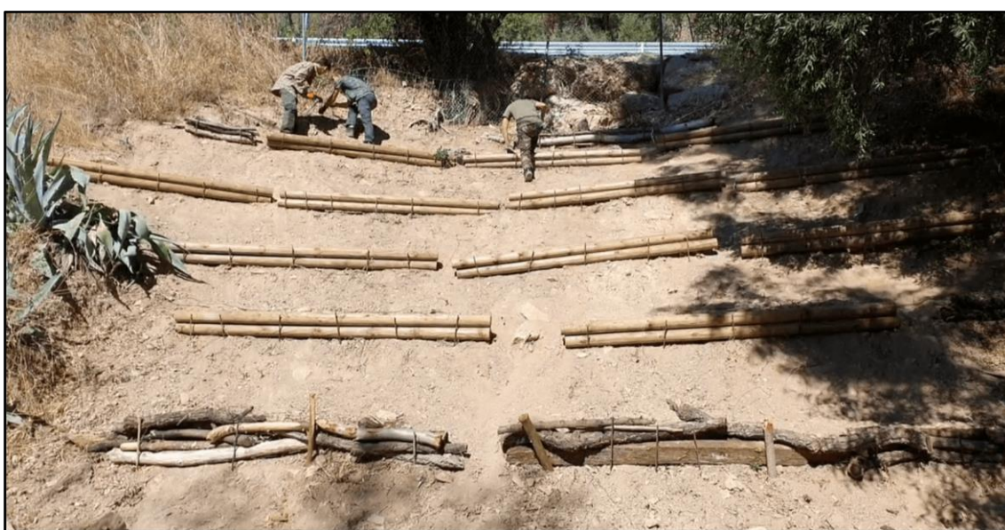
Ilustración 22: Ejemplo de fajina elaborada con troncos y estacas.
