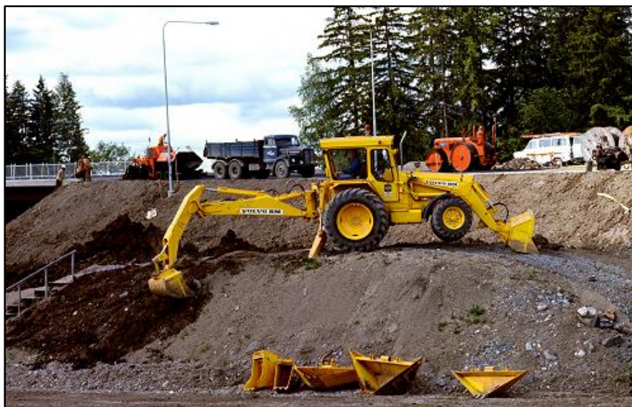
Ilustración 23: Extendido de tierra vegetal. Fuente: CYPE Ingenieros S.A
