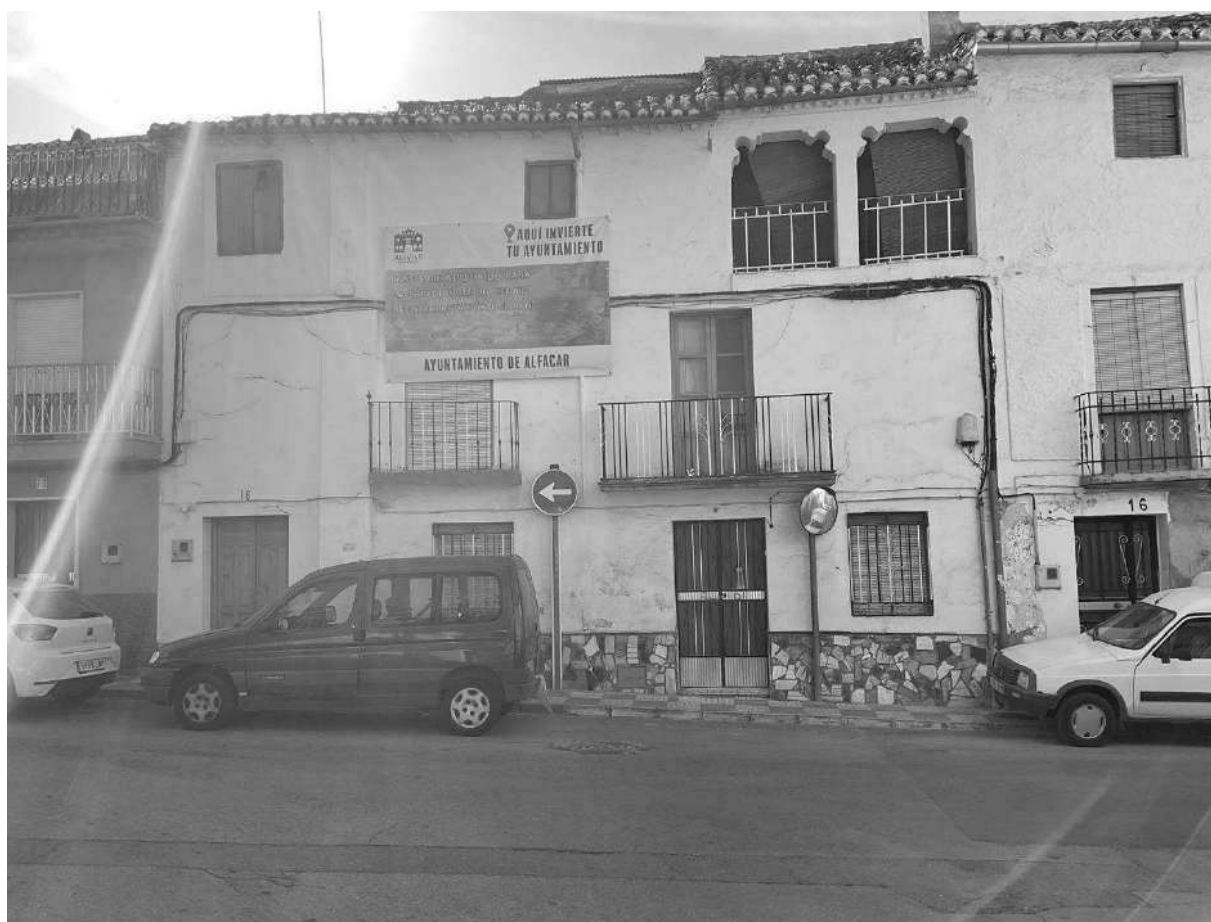
Fachada estado actual. Fotografía tomada en octubre de 2022 1
