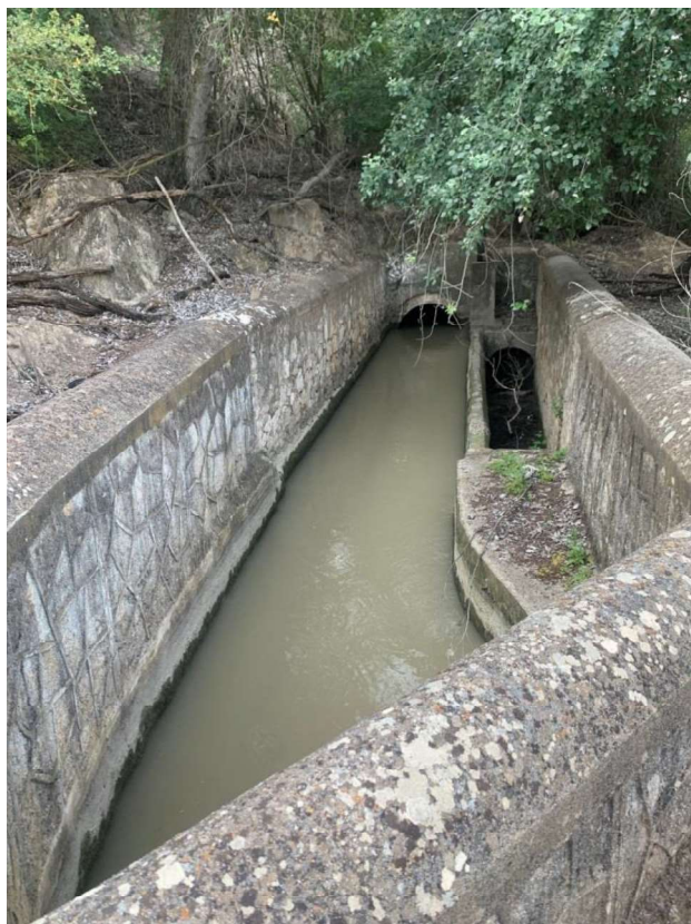
Figura 3. Parte del canal desembovedado
