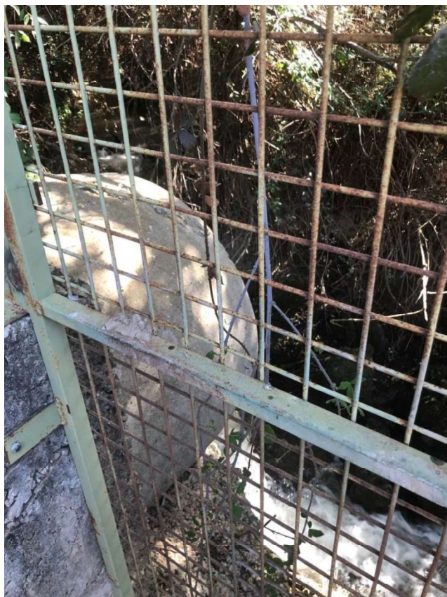
Figura 5. Caída del agua al final del canal
