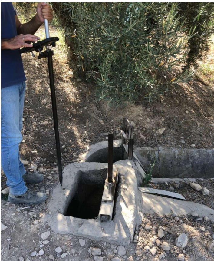
Figura 18. Primera zona abierta de la tubería.
