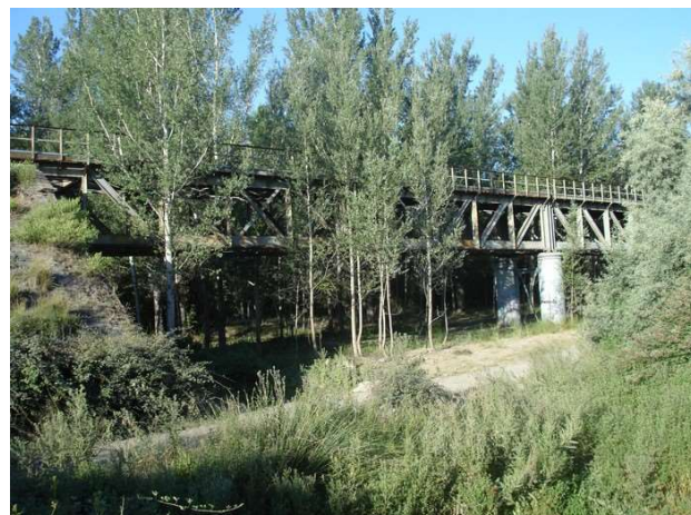
Puente de hierro (Caniles)
