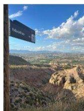
Falla de Baza
