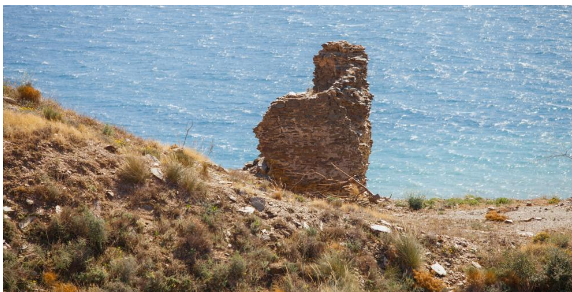
FOTO: TORRE DE HUAREA, TORRES CASTILLOS Y FORTALEZAS.
